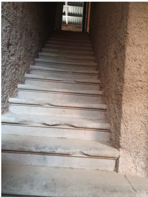
Vista di un vano scale
