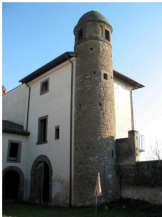
Vista del prospetto interno dal giardino
