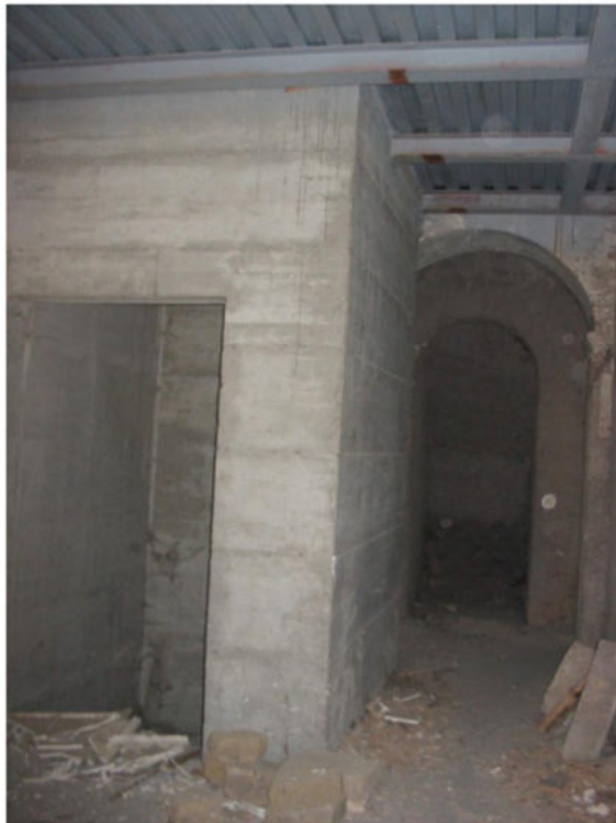
Vista del vano ascensore
