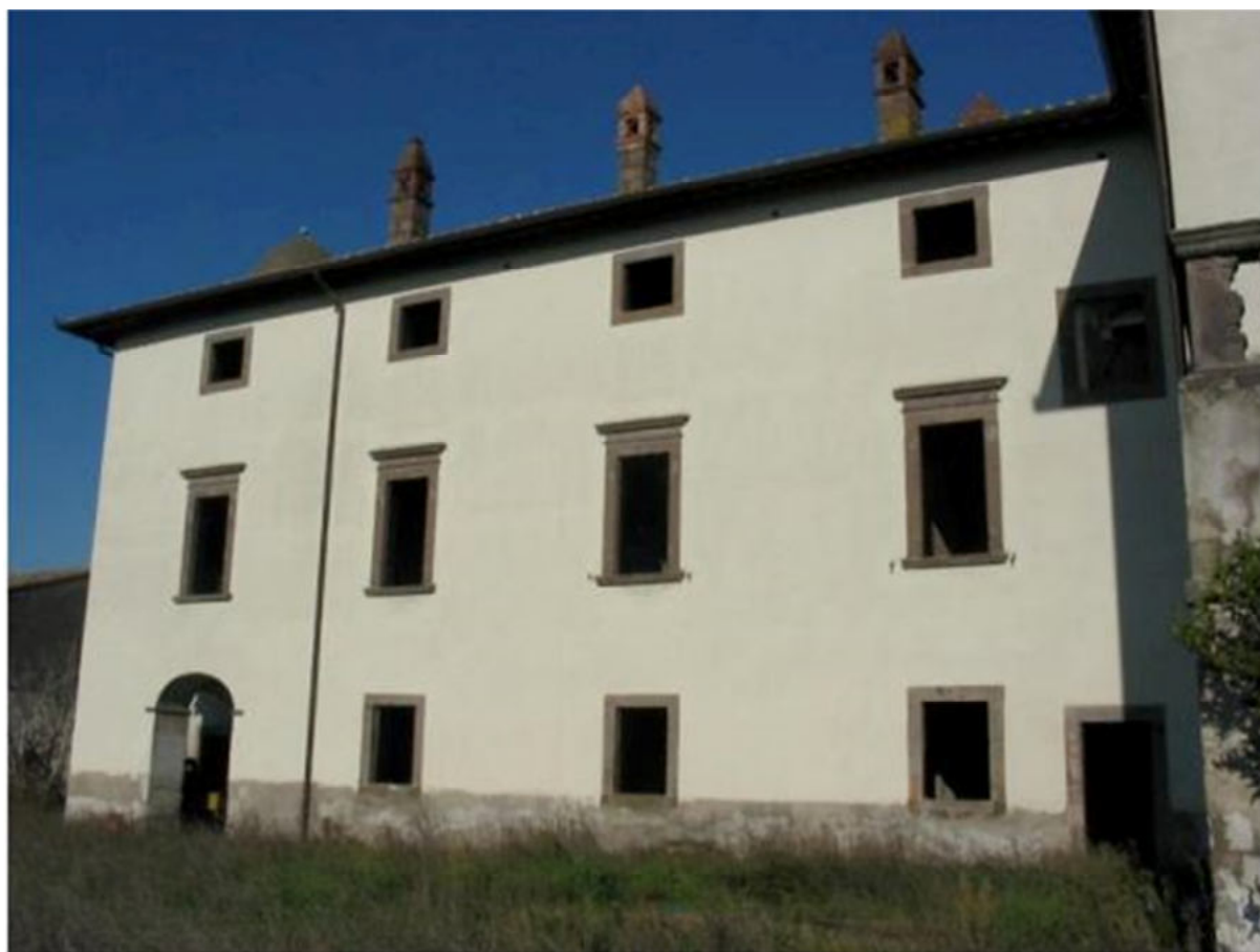
Vista del prospetto interno
