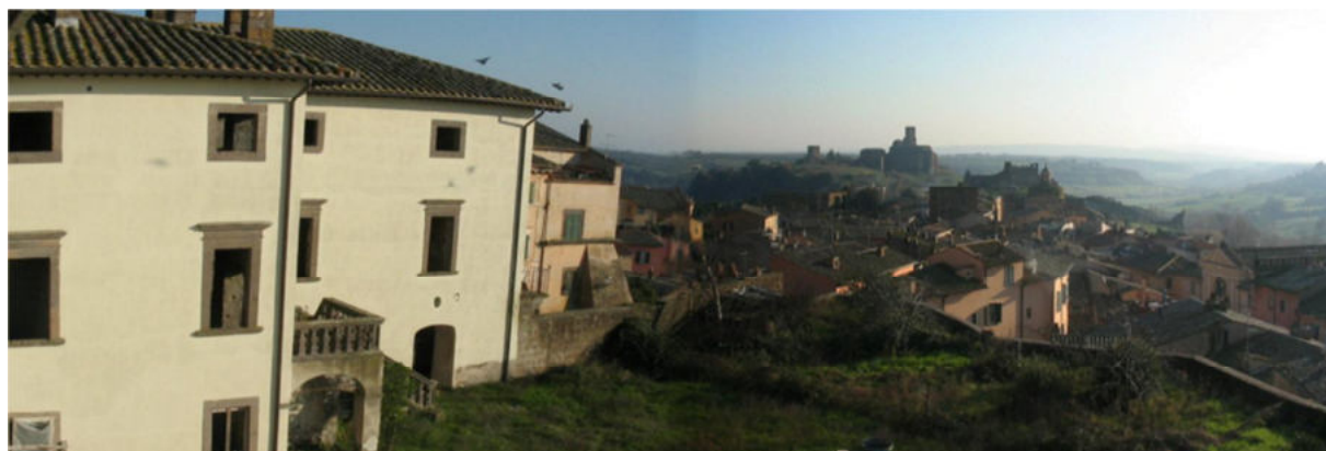
Vista del cortile panoramico
