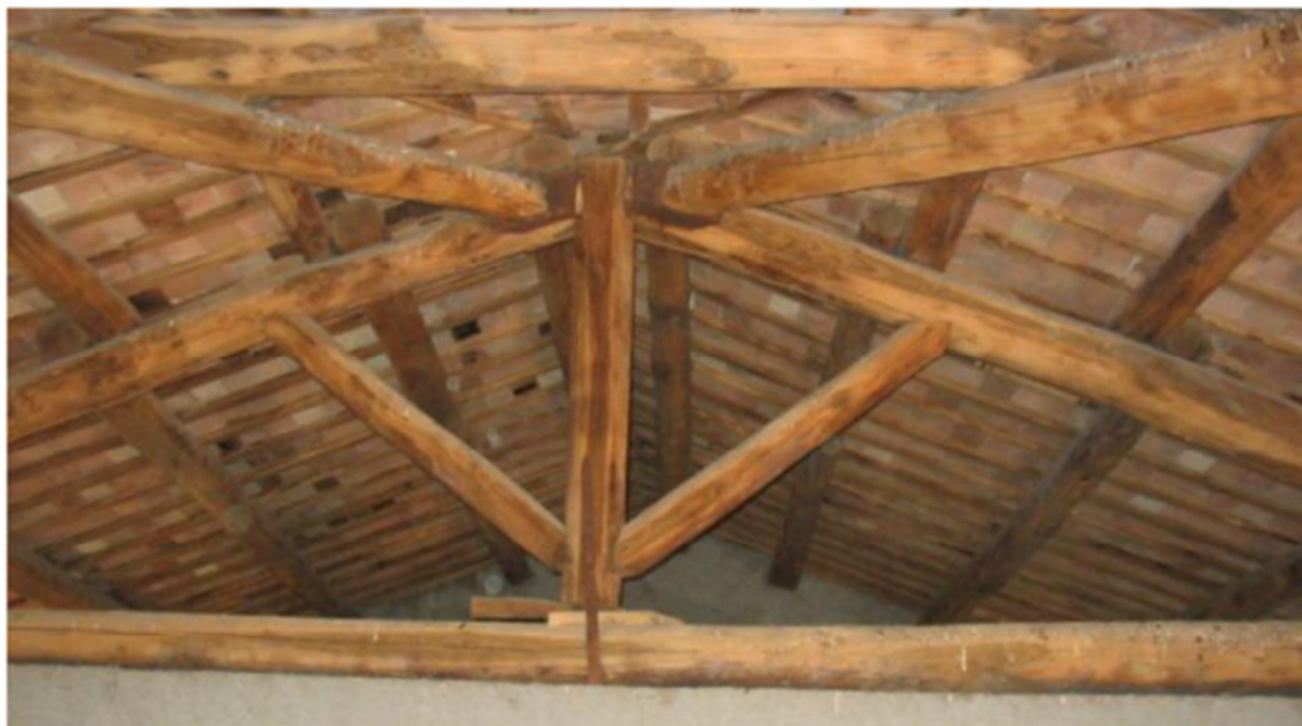
Vista di una porzione del tetto
